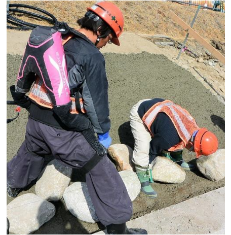
作業③：ランダムに並べられた石を、石工と呼ばれる職人が、高さが平らになるよう並べていく。最終的に堤防が平らに出来上がるかどうかは、この石工の腕次第。
