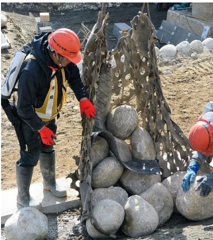
作業①：重機で下方より運ばれてくる大量の石を取り出し並べていく。1個あたり15kg前後の石を扱っている。
