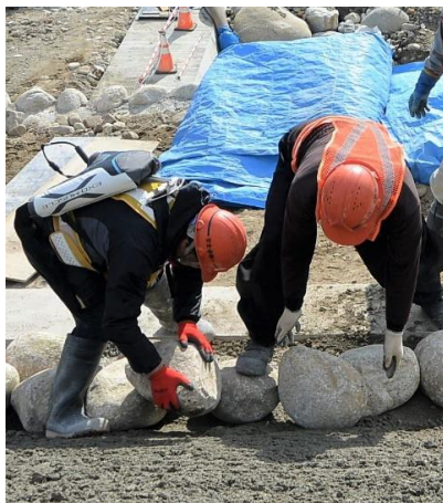
作業②：重機から降ろした石を持ち上げたり、中腰姿勢で動かして配置調整を行う。マッスルスーツ®がこの作業をサポートして身体の負担を軽減する。
