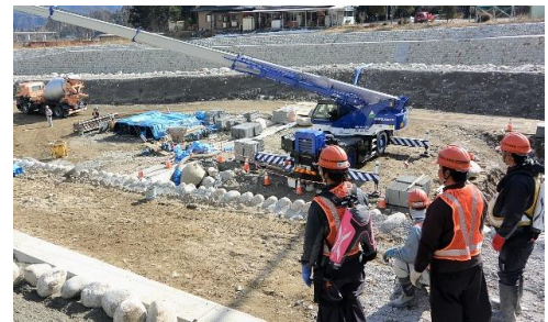
重機へ指示を出し、積んでいく石を下から運搬する様子。河川敷での工事は、このような連続した作業が多く、身体を痛めやすい。
