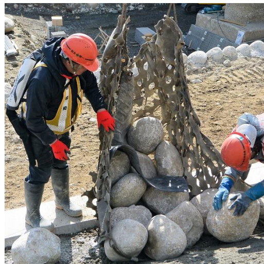
作業①：重機で下方より運ばれてくる大量の石を取り出し並べていく。1個あたり15kg前後の石を扱っている。
